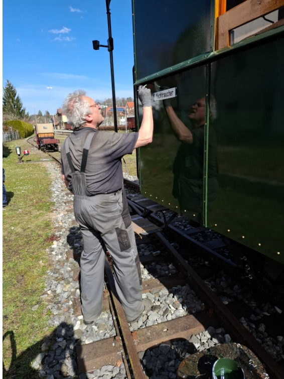
Gerhard Baum war am 22. März 2025 mit der Lackierung der 600 verzinkten Schrauben an Verblechung und Bühnen beschäftigt. Unten ein Portrait des Wagens am 02. Mai 2025 im Bahnhof Warthausen.
