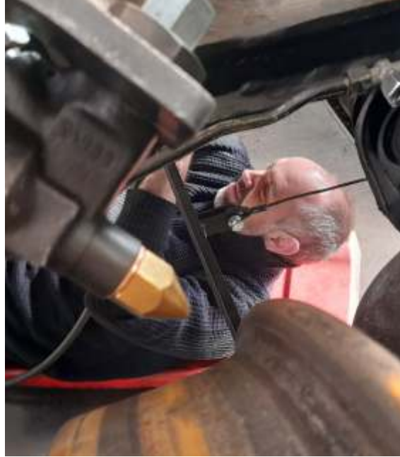
Blick über eine der neuen Spurkranz-Schmierdüsen auf den unter dem Drehgestell arbeitenden Alexander Bückle.
