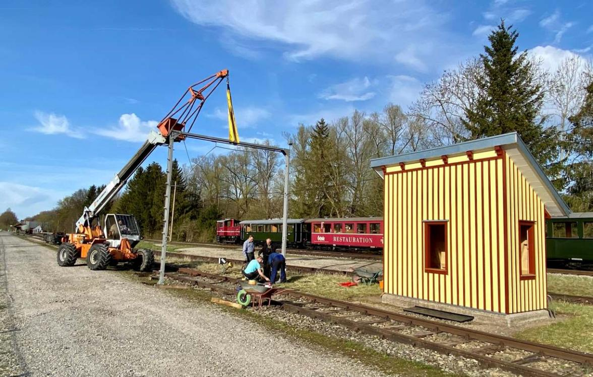
*Das frisch aufgearbeitete Lademaß wird am 13.04.2022 an der originalen Position aufgestellt.*
